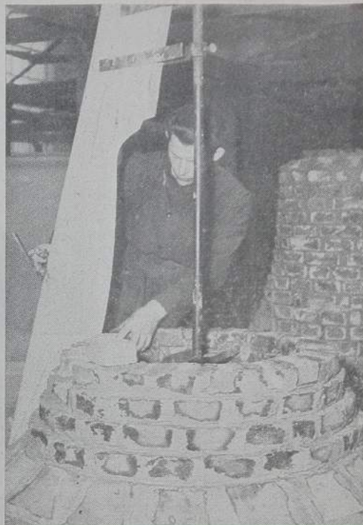
De kern in opbouw
